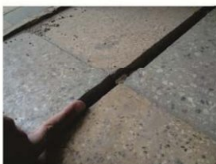
تصویر ۱۱: ترک پوشش زیرزمین در طبقه اول - بهمن ۱۳۸۸
