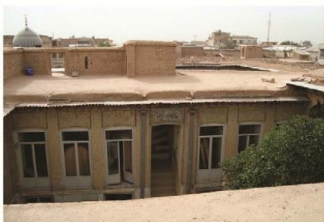
تصویر ۴: نمای غربی بیرونی - بهمن ۱۳۸۸
