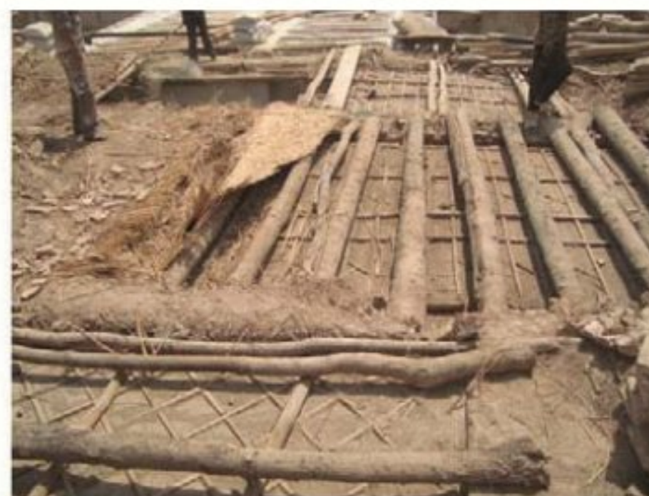
تصویر ۸: قرارگیری حصیر، نی، گل، و خاک دستی روی تیرهای اصلی- بهمن ۱۳۸۸
