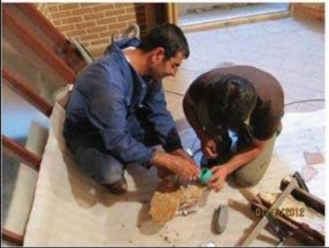
ت. ۱۲. وصالی و پایدارسازی قطعات در موقعیت اولیه با استفاده از رزین اپوکسی (ماخذ: نگارندگان)
