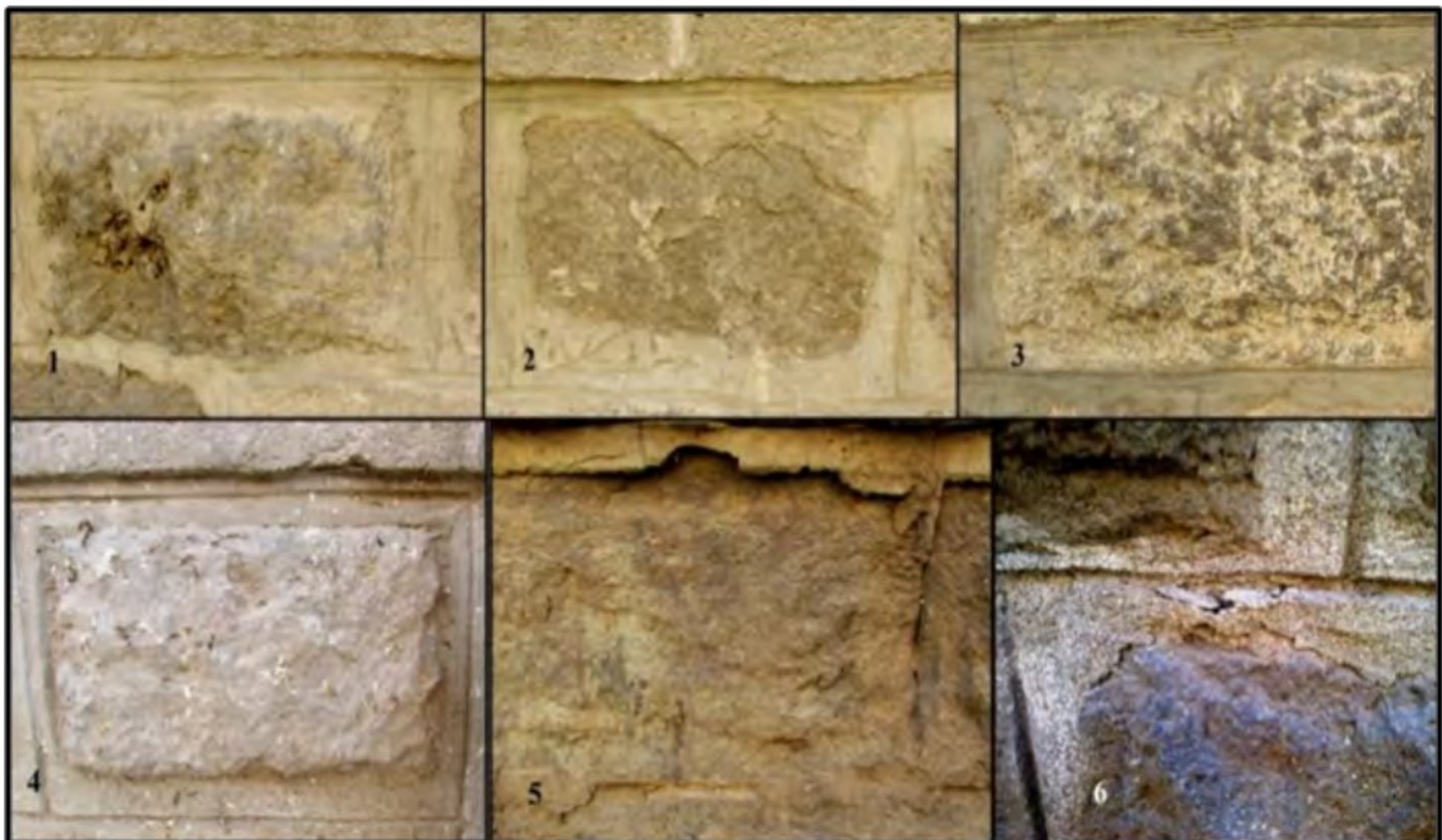
تصویر ۲. حجم بالای رسوبات محیطی و فضولات بر سطح سنگ‌ها (شماره‌های ۳ و ۴) و استفاده از ملات ماسه سیمان موجب از دست رفتن بخش‌هایی از سنگ‌ها ۱، تورق سطح سنگ‌ها ۲، خورده شدن مغز سنگ‌ها و باقی ماندن ملات تخریب کننده ۵ و در نهایت تاول و پوسته شده. ملات بر اثر نهان‌شکستگی نمک در زیر ملات ۶ شده است.
