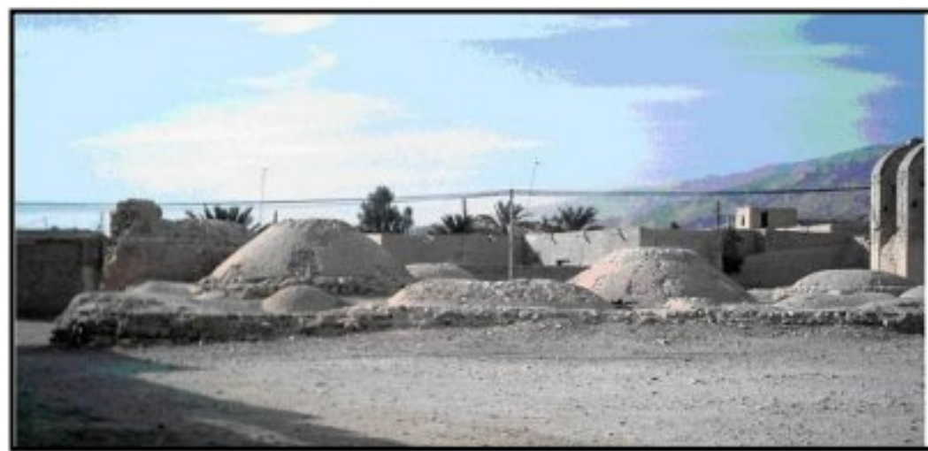
تصویر ۲. نمای جنوبی حمام - مهر ۱۳۸۳
