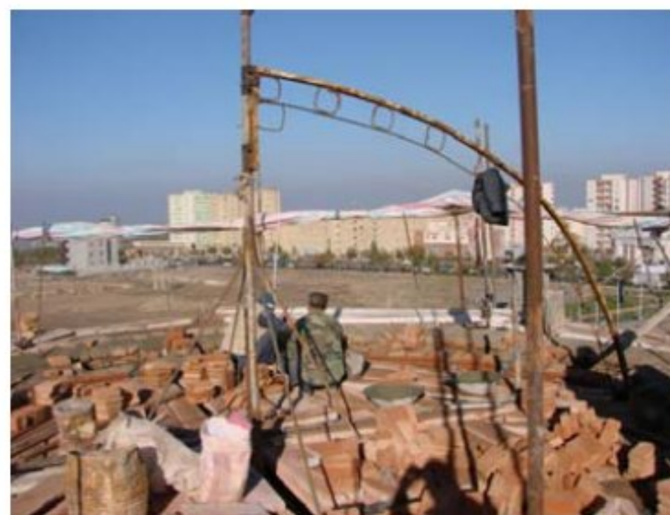
تصویر ۵: نمایی از روش اجرای قالب گردون و شماتیک ترسیمی آن
