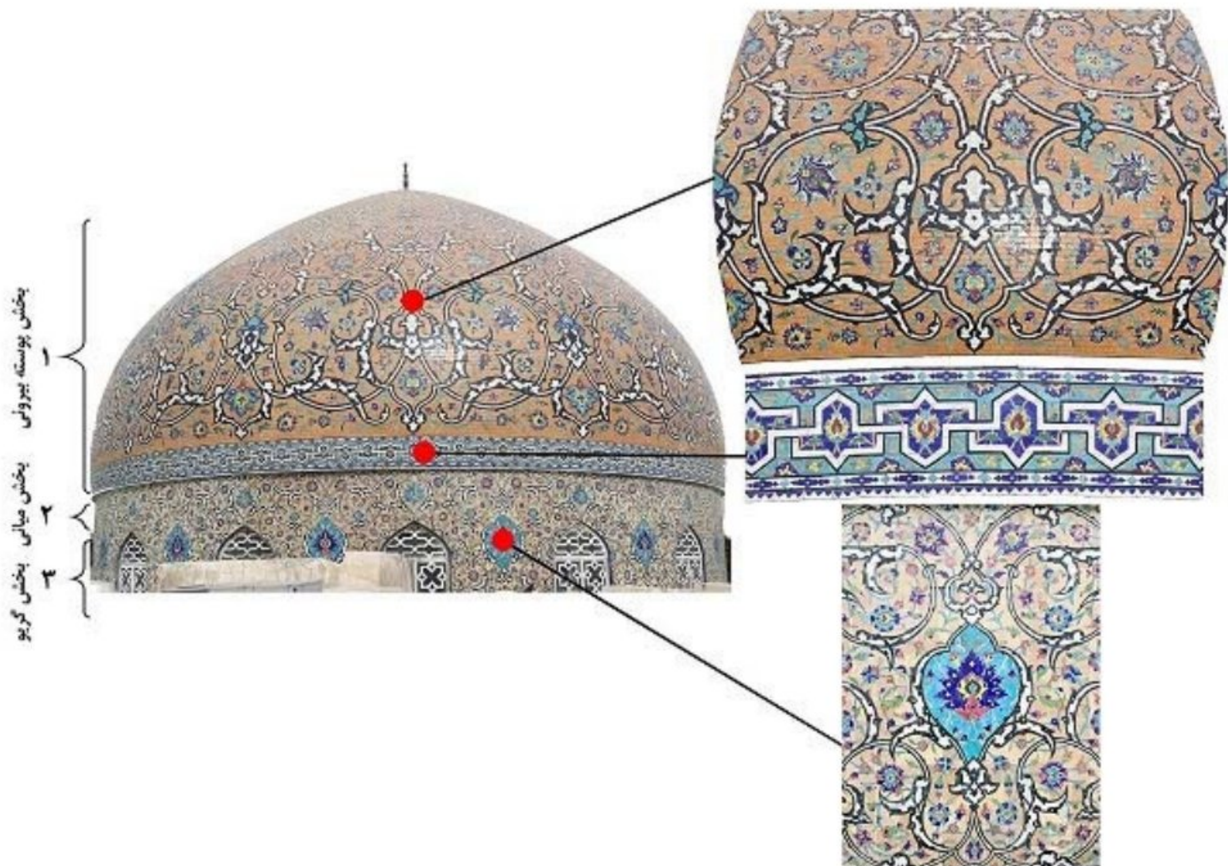
شکل ۴. جزئیات کاشی کاری در پوسته بیرونی گنبد کاخ مرمر تهران (مأخذ: نگارندگان)
