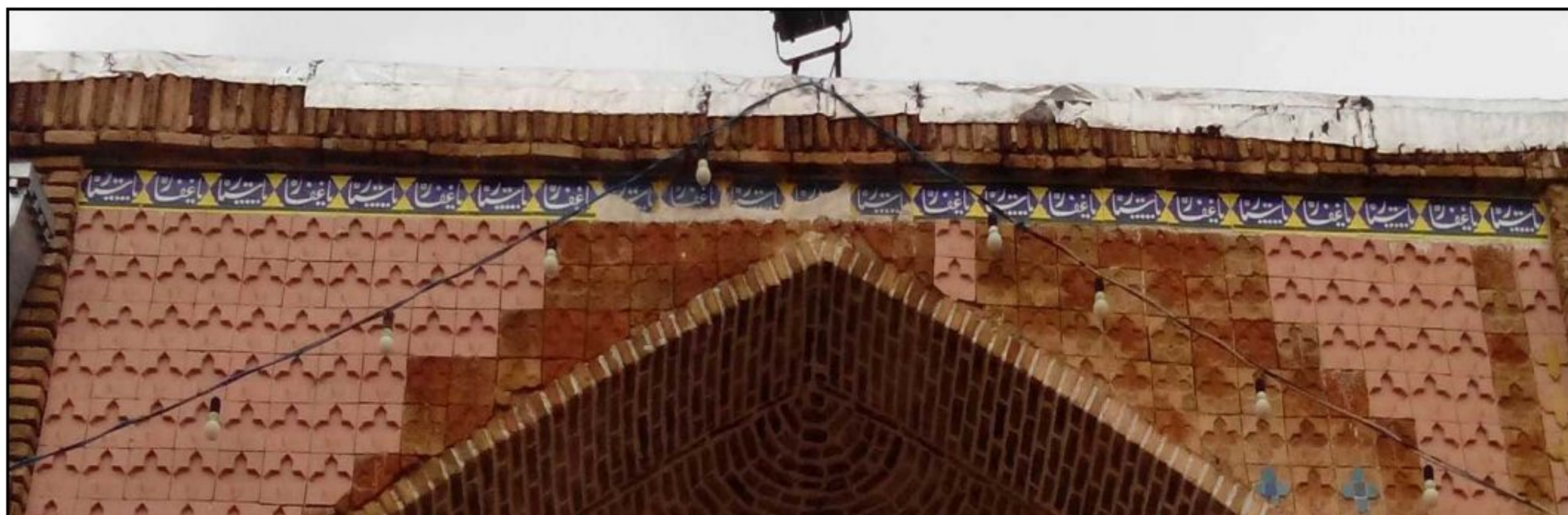
تصویر ۱۲. وضعیت آرایه‌های کاشی پس از نصب و نحوه قرارگیری کاشی‌های تاریخی و جدید
