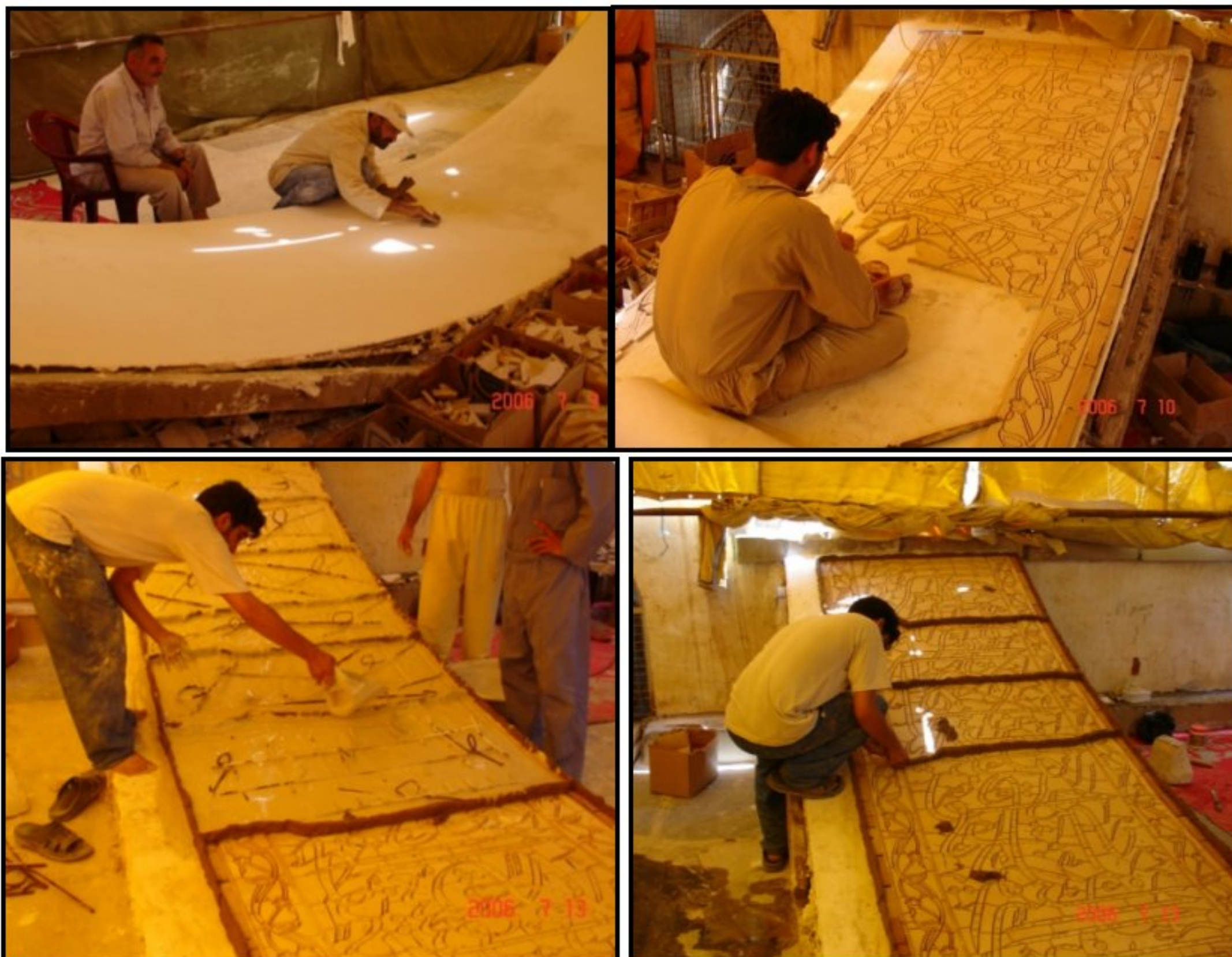
تصویر ۷- مراحل اجرای ساقه گنبد امام جواد (ع)
