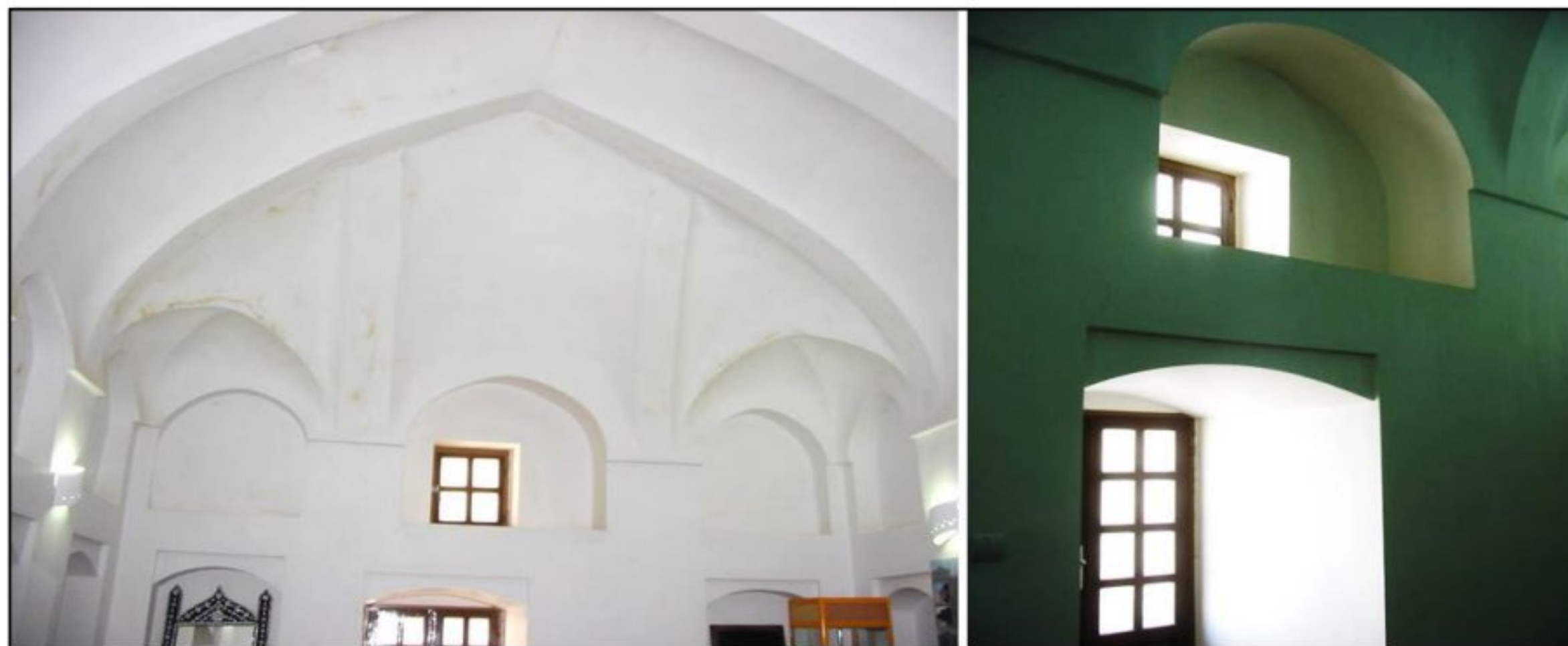
تصویر ۱۰: تعبیه پنجره و نورگیری اتاق‌ها (نگارندگان، ۱۳۹۴)
