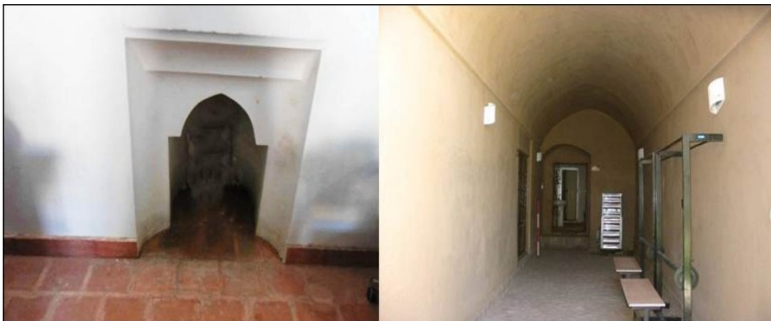
تصویر ۱۳: راست: طاق گهواره‌ای در دالان گوشه جنوب شرقی چپ: وجود بخاری در اتاق نشیمن (نگارندگان، ۱۳۹۴)
