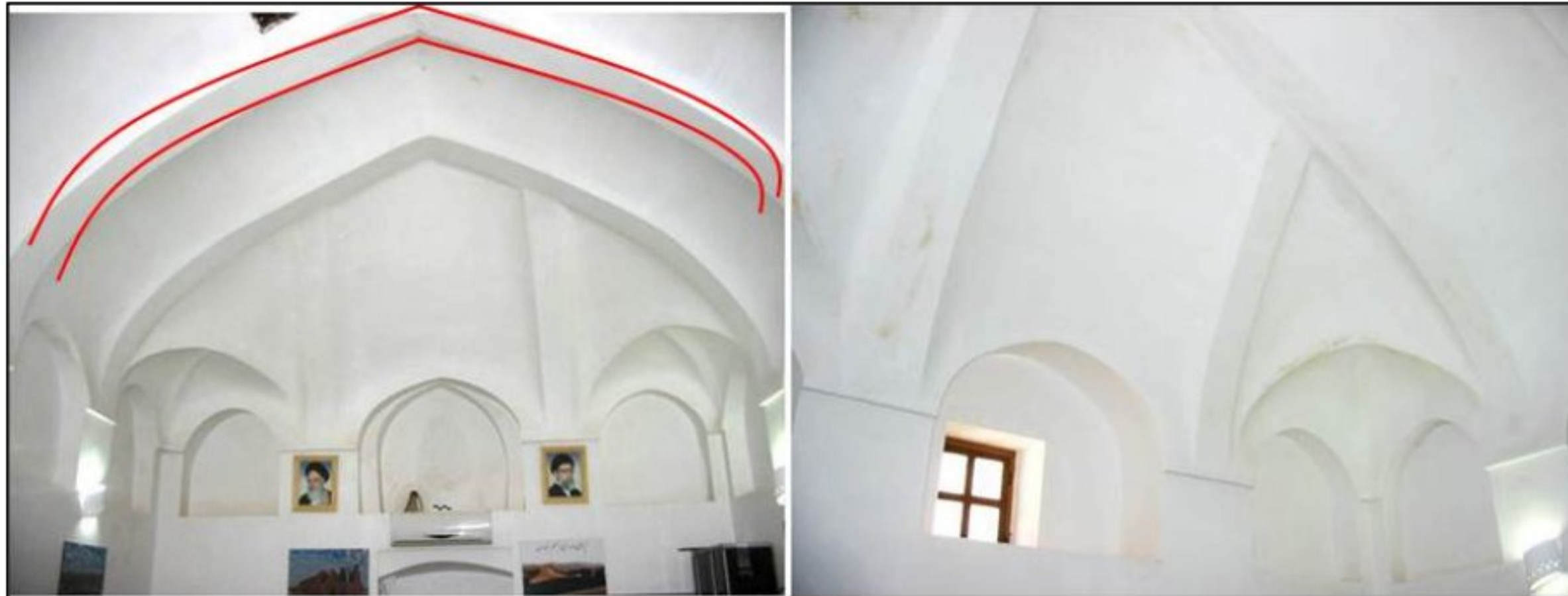
تصویر ۹: راست: گوشه سازی اسکنج چپ: پوشش طاق و تویزه اتاق میهمان در ضلع شمالی (نگارندگان، ۱۳۹۴)
