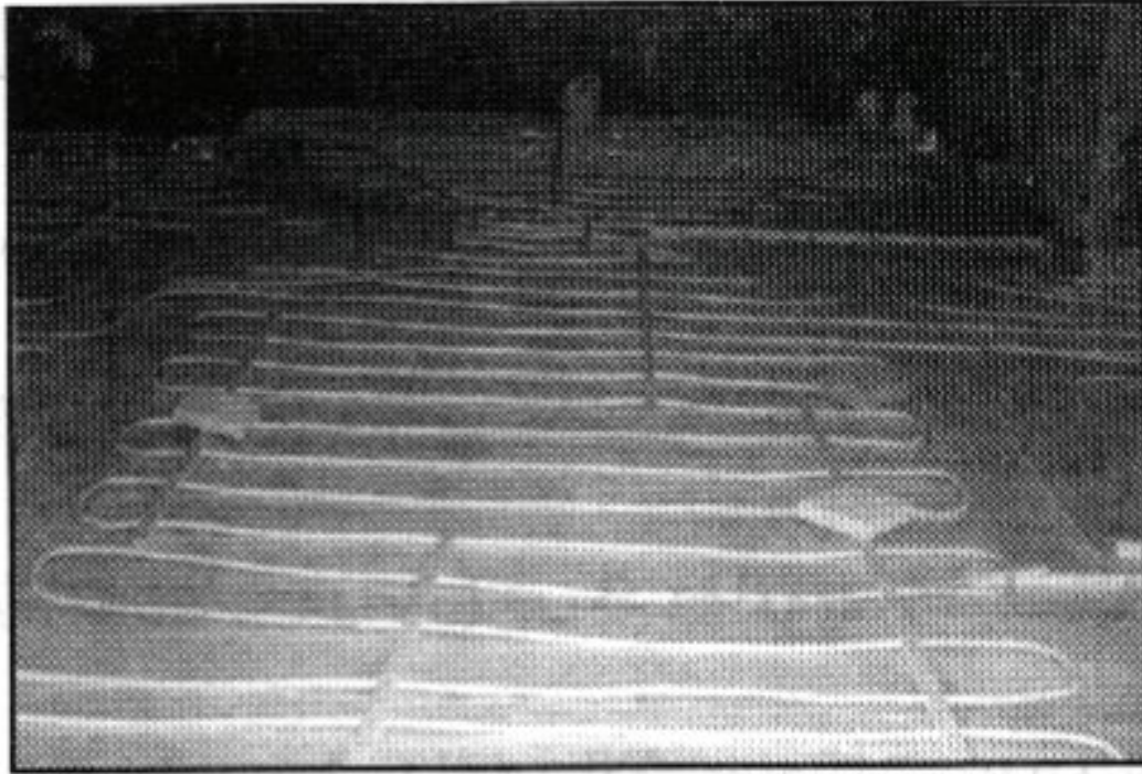
نصب شبکه‌ی لوله‌های پنج لایه پس از عایق‌بندی کف
