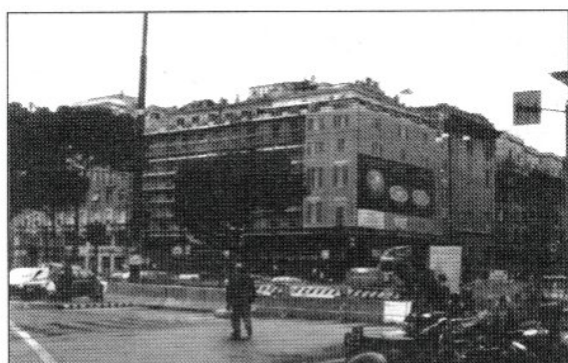
۱۹- پوشش‌های مصور با تصویر بخشی از نمای تاریخی بر روی داربست (شهر رم)
