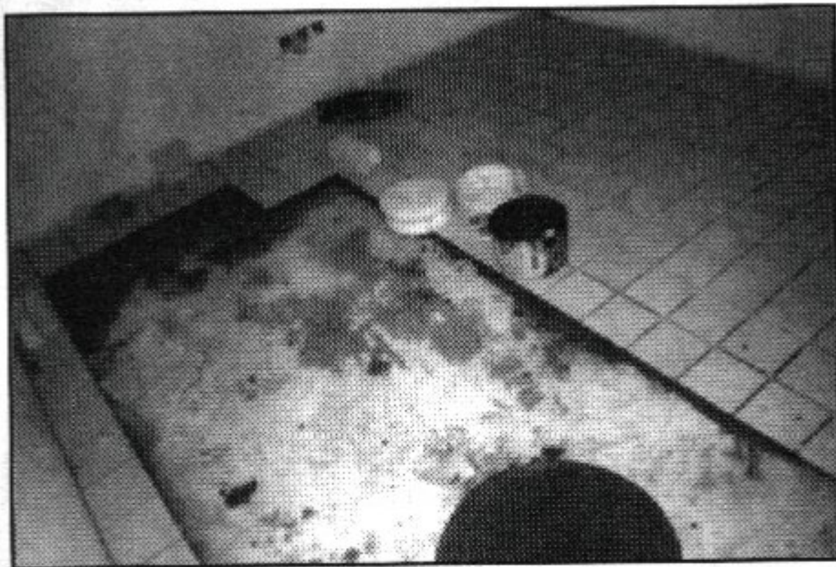
اجرای کففرش نهایی با سرامیک در یکی از چله‌نشین‌های خانقاه
