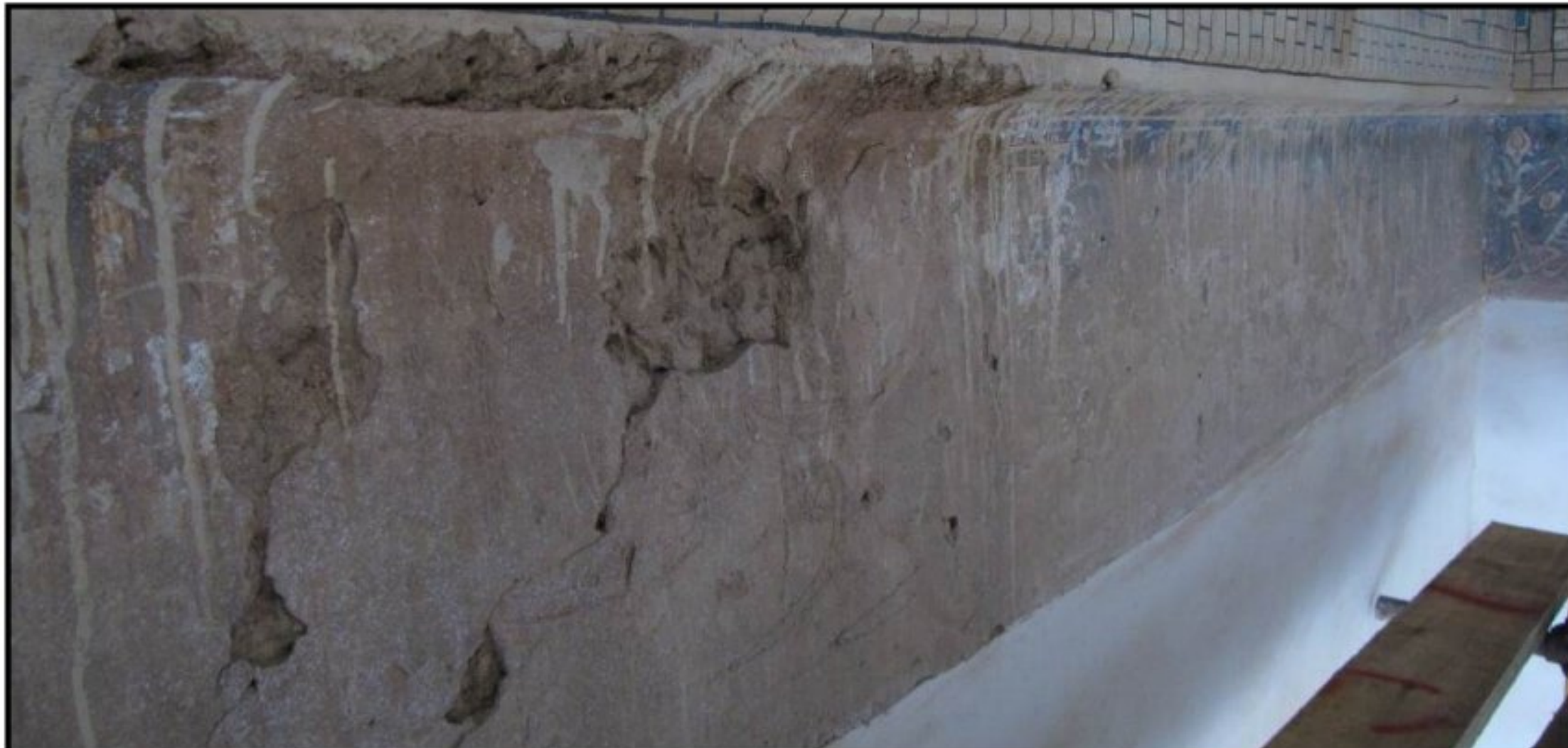
شکل ۲۶. زوال و تخریب لایه‌های مختلف کتیبه نقاشی مسجد جامع کبیر یزد و ناخوانا شدن کتیبه
