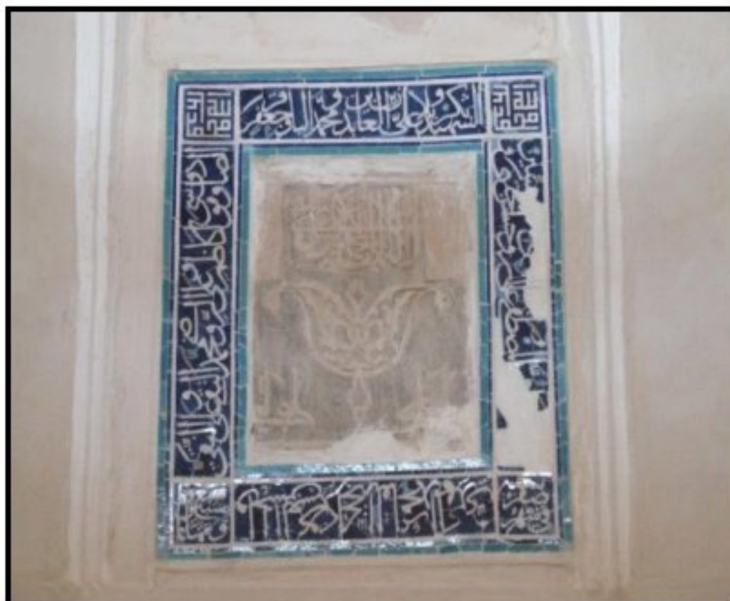
اشکال ۲۶ تا ۲۸. دوغاب‌ریزی گچ پشت کتیبه- پر کردن بخش ناپیوستگی کنار کتیبه با گل-کتیبه کاشی پس از نصب و بازسازی حمیل
