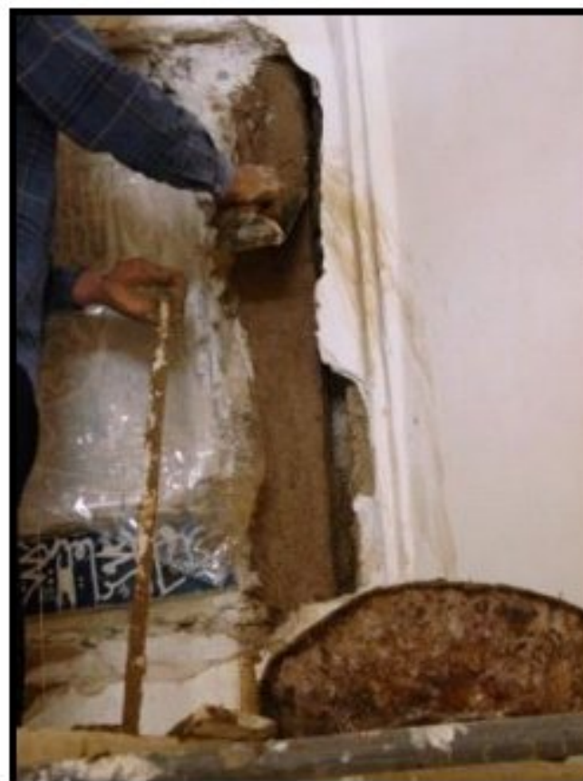
اشکال ۲۶ تا ۲۸. دوغاب‌ریزی گچ پشت کتیبه- پر کردن بخش ناپیوستگی کنار کتیبه با گل-کتیبه کاشی پس از نصب و بازسازی حمیل
