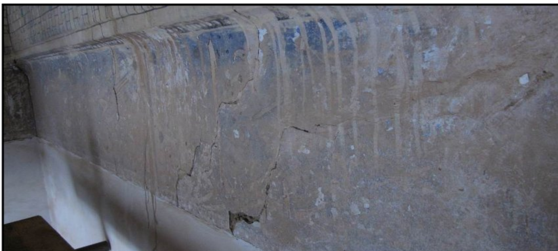
شکل ۲۷. زوال و تخریب لایه‌های مختلف کتیبه نقاشی مسجد جامع کبیر یزد و ناخوانا شدن کتیبه
