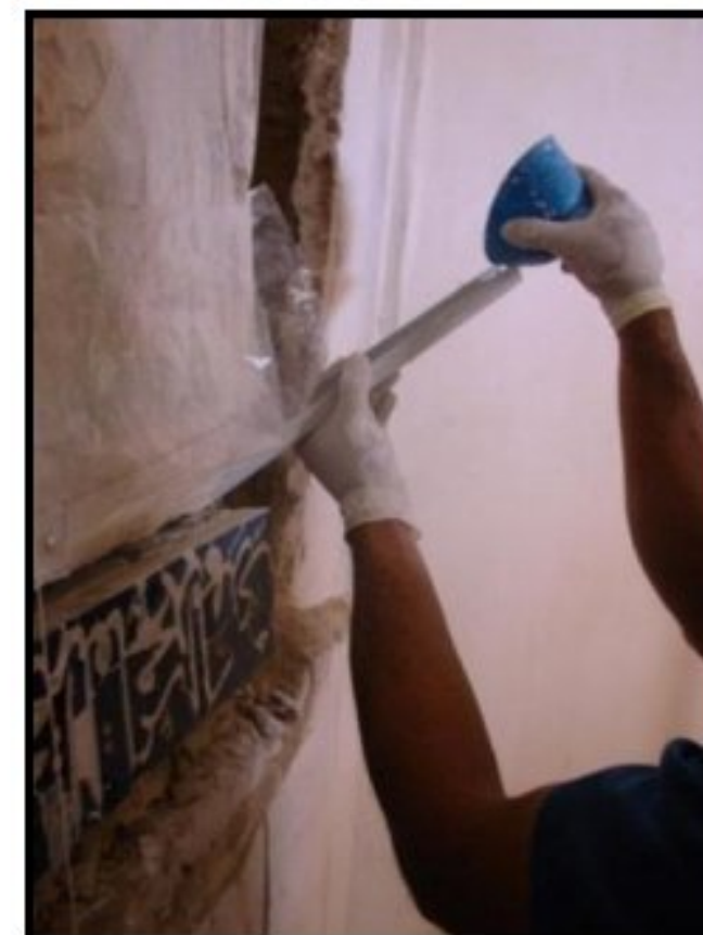
اشکال ۲۶ تا ۲۸. دوغاب‌ریزی گچ پشت کتیبه- پر کردن بخش ناپیوستگی کنار کتیبه با گل-کتیبه کاشی پس از نصب و بازسازی حمیل
